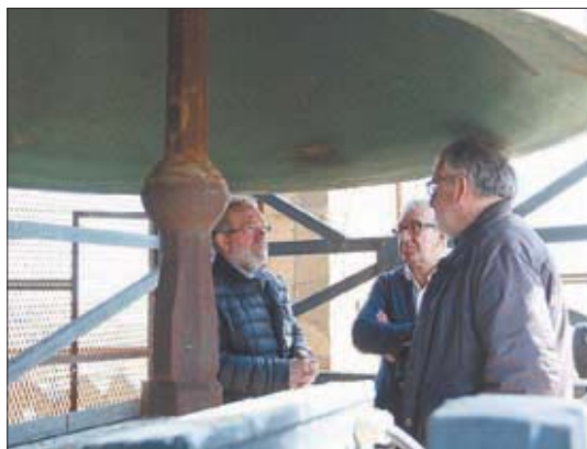
FOTO: Diputación/ La colaboración permite reparar las campanas
