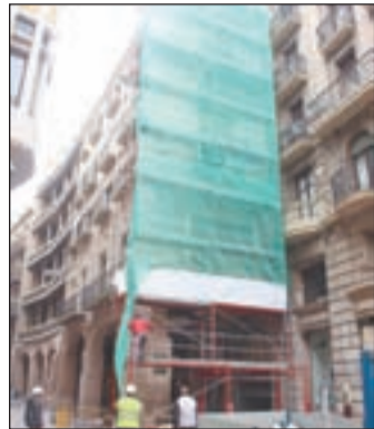
FOTO: Tony Alcántara/ Andamio en la fachada afectada
